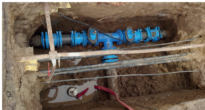
Die Erneuerungen der Hauptschiebergruppen konnten rasch abgeschlossen werden.
